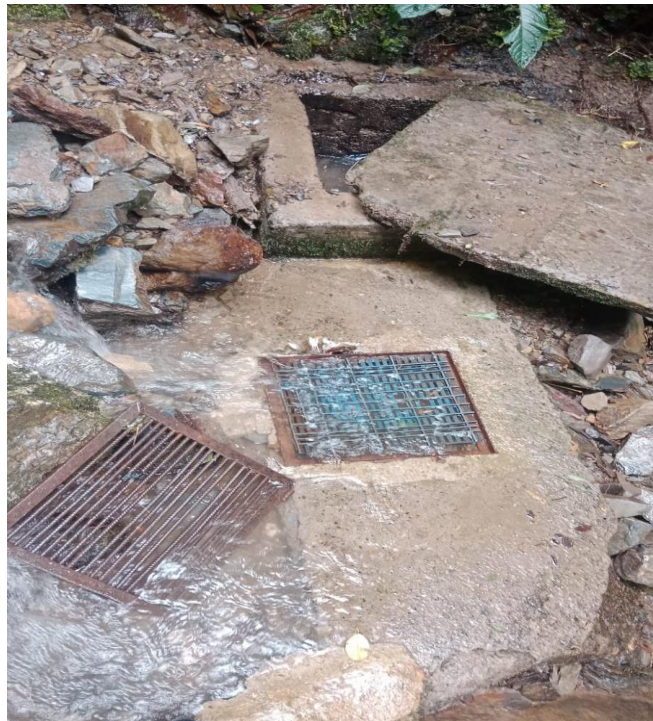
Ilustración 9: Bocatoma acueducto alto del rayo.
