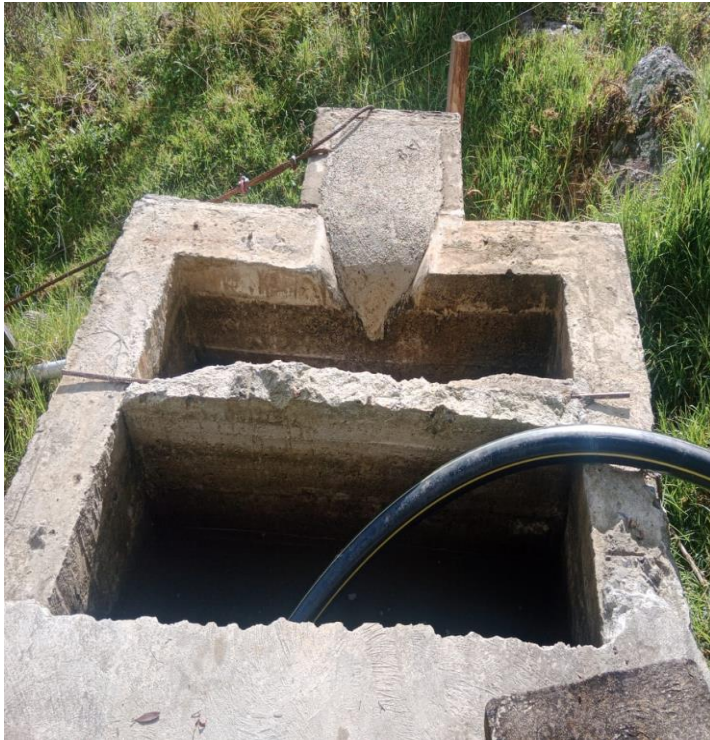
Ilustración 13: Desarenador acueducto palo largo.
