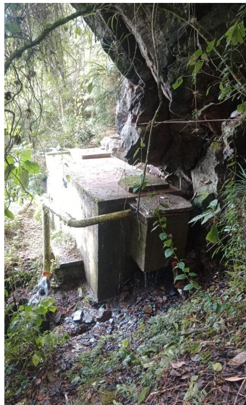
Ilustración 3: Desarenador del acueducto el alto del rayo.
