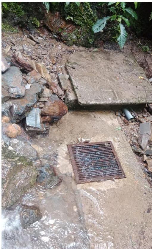
Ilustración 2: Bocatoma en la quebrada de la purniana.
