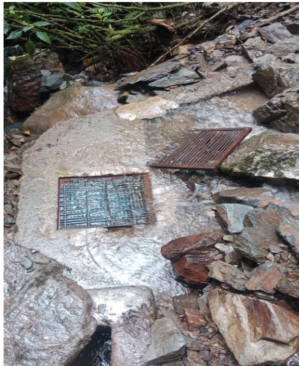
Ilustración 10: Bocatoma acueducto el alto del rayo.
