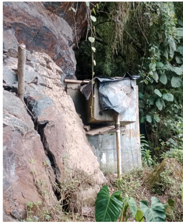
Ilustración 12: Desarenador acueducto el alto del rayo.
