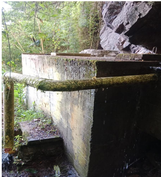
Ilustración 11: Desarenador acueducto el alto del rayo.
