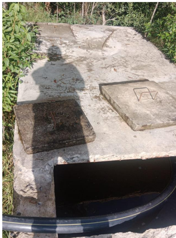
Ilustración 7: Desarenador del acueducto.
